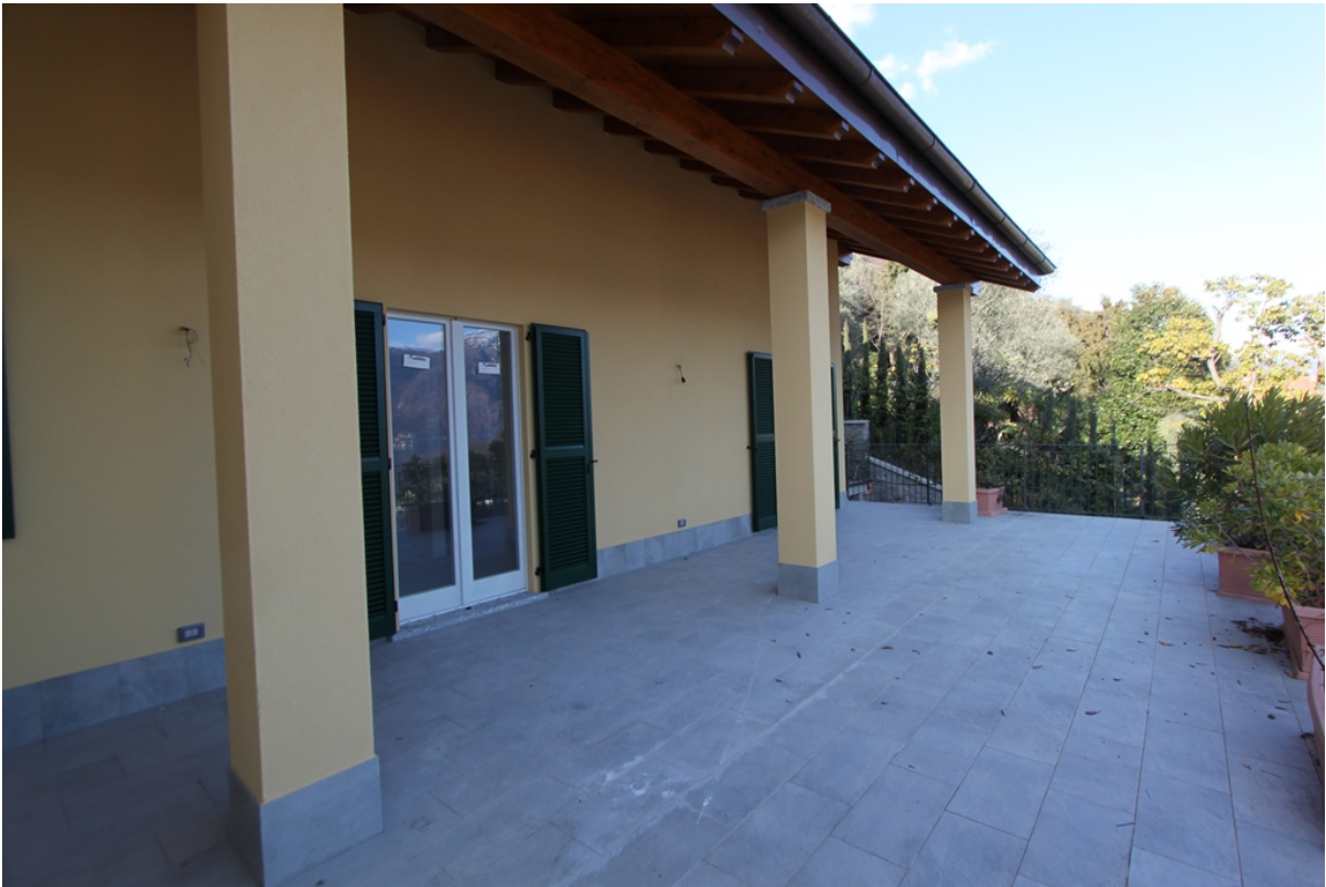
Объект: Две независимые виллы на озере Комо Расположение: Италия Озеро Комо Оссуччо
