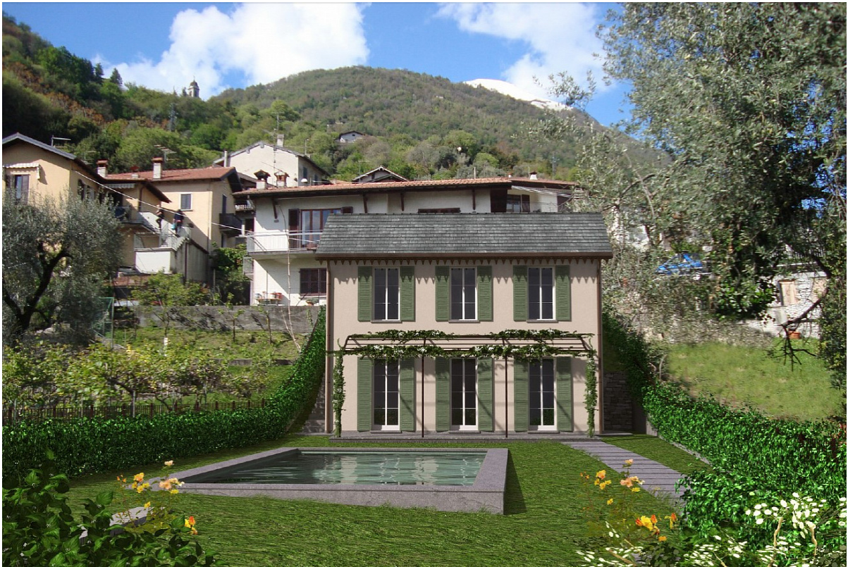
Объект: Строительный проект на озере Комо Расположение: Италия Озеро Комо Оссуччо
