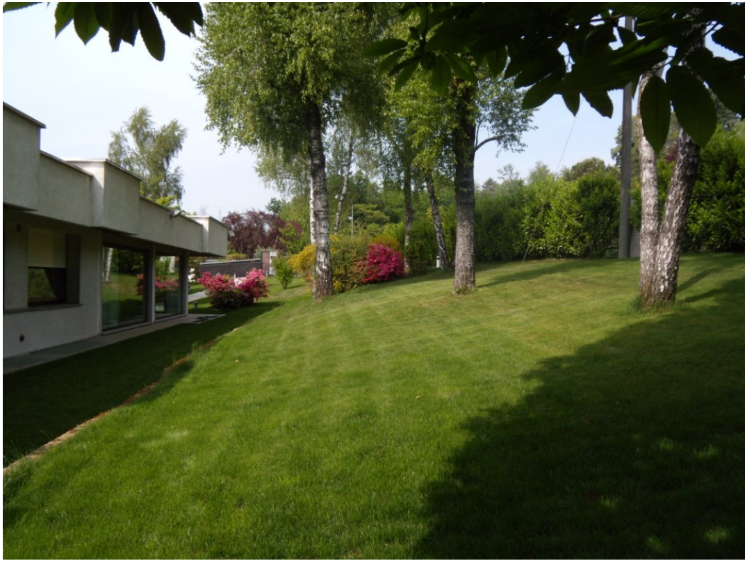
Объект: Современная вилла недалеко от озера Маджоре Расположение: Италия Озеро Маджоре Безнате
