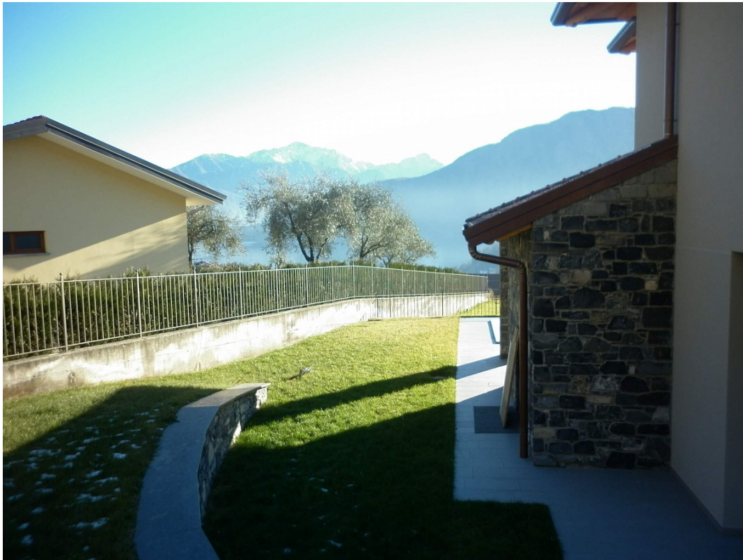
Объект: Вилла в Ленно с панорамным видом Расположение: Италия Озеро Комо Ленно
